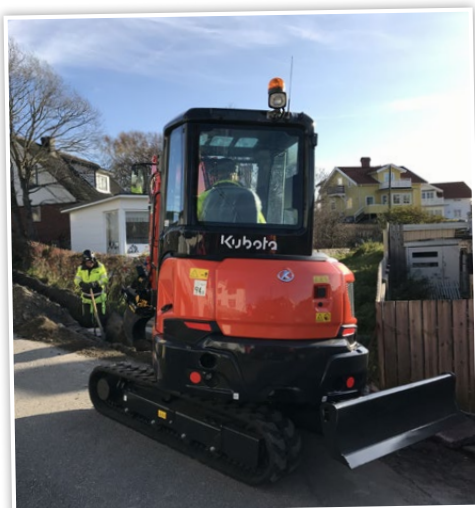
Arbetet är i full gång med nya Kubota KX037-4
