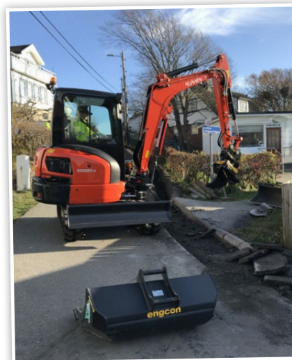
Isolerade kablar som grävs ner i marken
